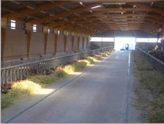
Parcours avec bandes vissées au sol
